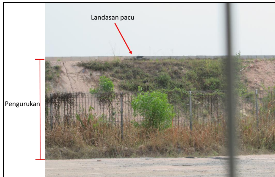
Gambar 27. Rekayasa morfologi berupa pengurukan di Bandara Raden Inten II.
